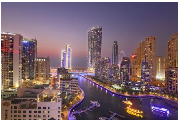
Mögliche Aussicht - Wohngebäude - Dubai
