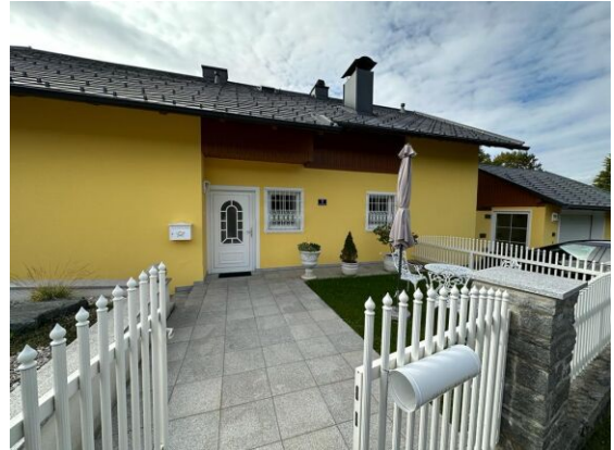
EG Eingang außen.
