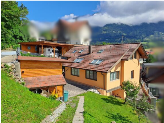
Südöstliche Ansicht mit Blick auf die gesamte Liegenschaft
