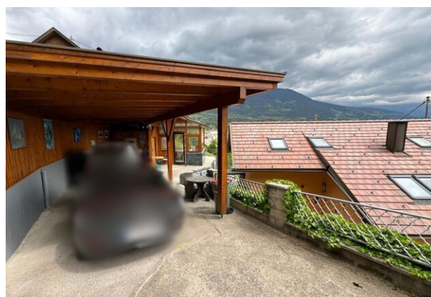
Carport - Wintergarten und Haus von oben
