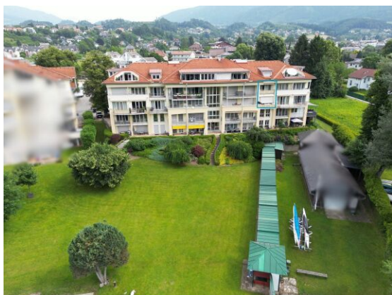
Liegenschaft von oben und Objekt.
