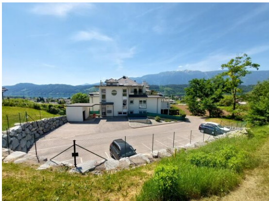
Anlage und Außenstellplätze
