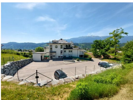
Anlage und Außenstellplätze
