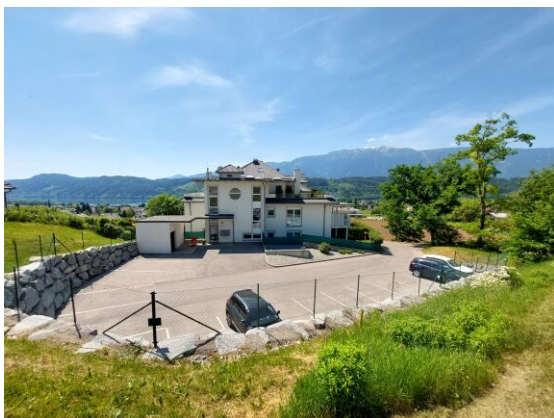
Anlage und Außenstellplätze
