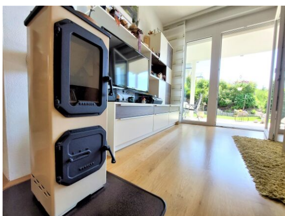
Holzofen im Wohnbereich
