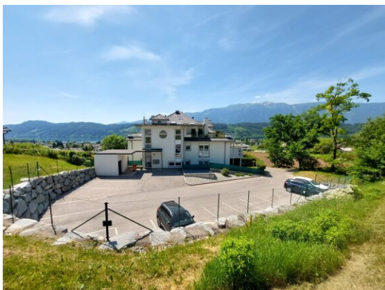
Anlage und Außenstellplätze
