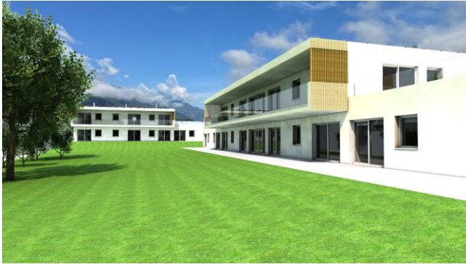
Südansicht Haus A und Ostansicht Haus B.
