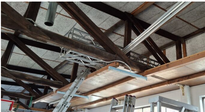
Höhe und Deckenaufbau.
