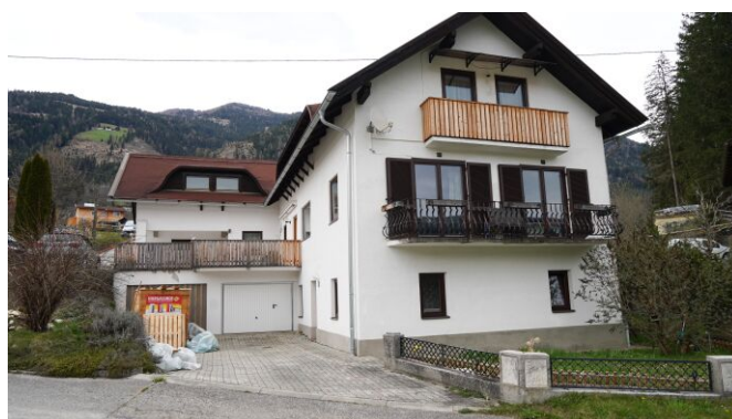
Außenansicht + Zugang Garage und KG.
