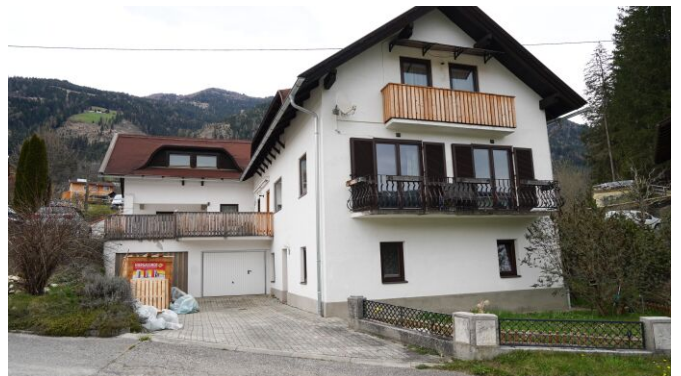
Außenansicht + Zugang Garage und KG.
