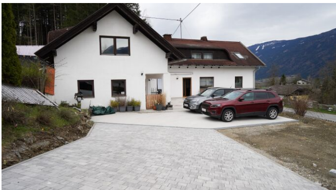
Außenansicht + Zugang EG.
