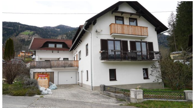
Außenansicht + Zugang Garage und KG.
