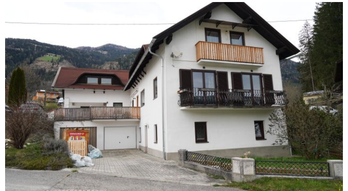
Außenansicht + Zugang Garage und KG.
