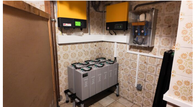
Stromspeicherung Photovoltaik
