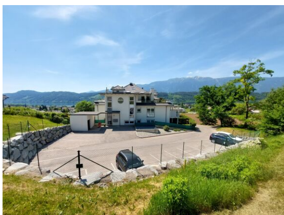
Anlage und Außenstellplätze
