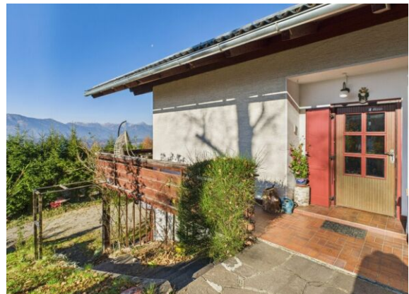
Eingangsbereich und Balkon EG.
