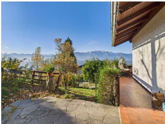
Eingangsbereich und Balkon EG.
