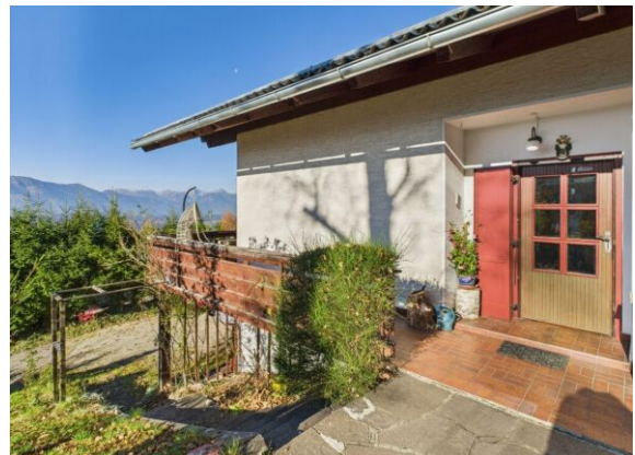
Eingangsbereich und Balkon EG.
