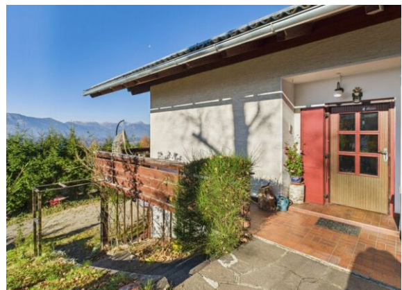
Eingangsbereich und Balkon EG.
