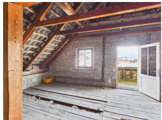
Rohdachboden inkl. Balkon.
