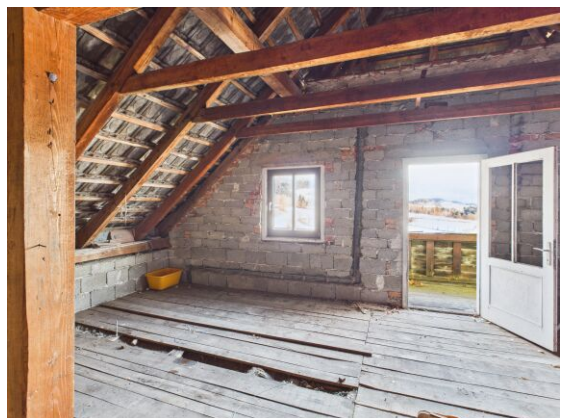
Rohdachboden inkl. Balkon.
