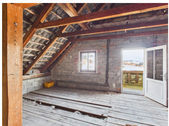
Rohdachboden inkl. Balkon.
