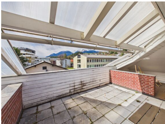
Terrasse (Richtung Westen).
