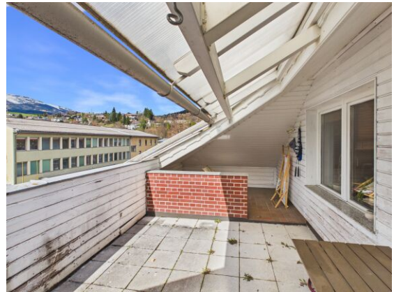
Terrasse (Richtung Westen).
