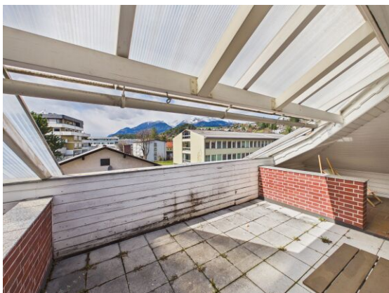
Terrasse (Richtung Westen).
