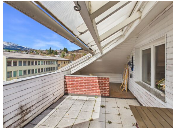
Terrasse (Richtung Westen).
