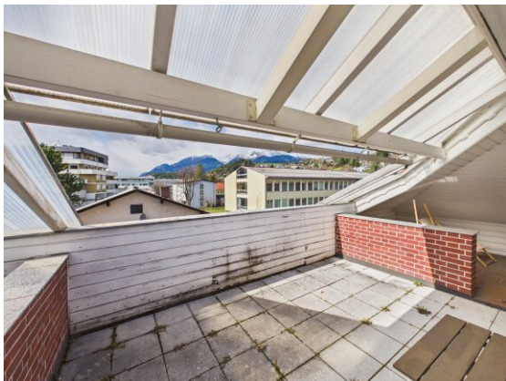
Terrasse (Richtung Westen).
