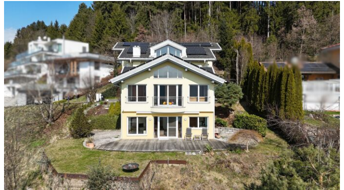
Südansicht Grundstück und Haus.
