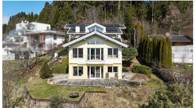
Südansicht Grundstück und Haus.
