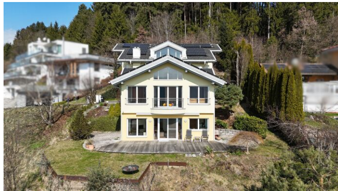
Südansicht Grundstück und Haus.
