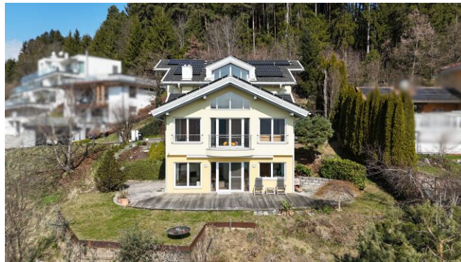
Südansicht Grundstück und Haus.
