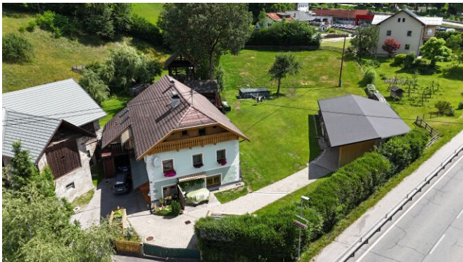
Drohnenaufnahme mit Schuppen (rechts) und Baugrundstück (nördlich).
