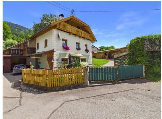
Einfahrt und Außenansicht.
