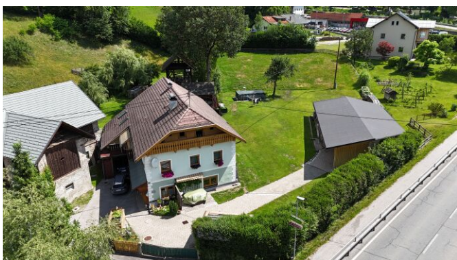
Drohnenaufnahme mit Schuppen (rechts) und Baugrundstück (nördlich).
