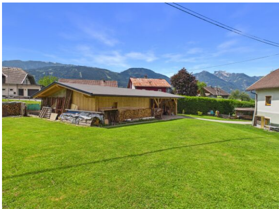
Schuppen und Grundstück.
