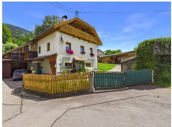
Einfahrt und Außenansicht.
