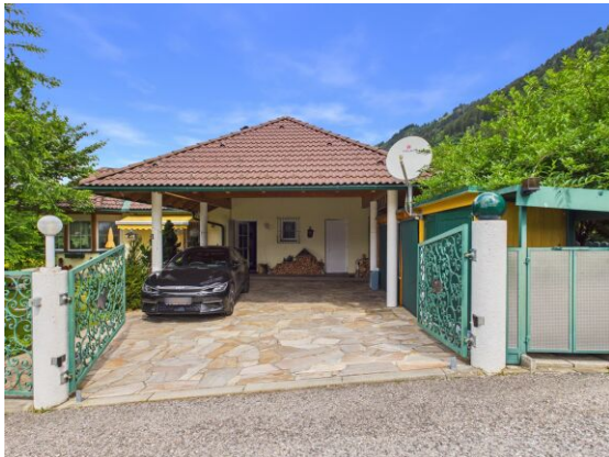
Carport und Zugang Haus.
